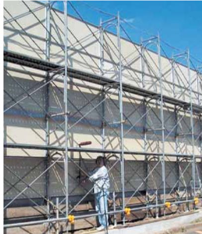
追加防音壁の設置施工
