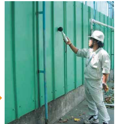
施工後の遮音性能確認計測
